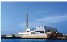
バイオマス発電《ごみ処理》
