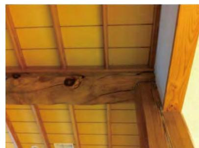
写真7-11 ねじれ対策の補修
