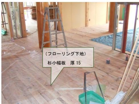
写真5-9 床下地への端材利用
