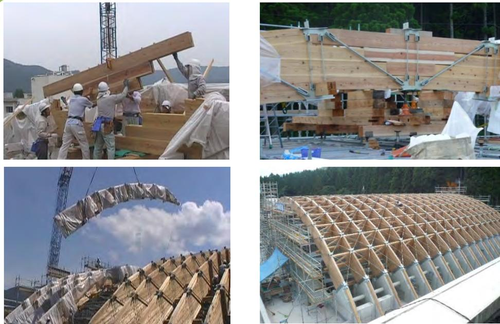
写真5-16 複合アーチばりの施工現場
