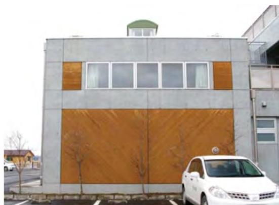
写真7-6 外壁木部の塗料落ち有り
