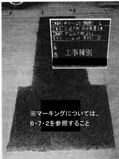
道路内仮復旧完了状況写真
