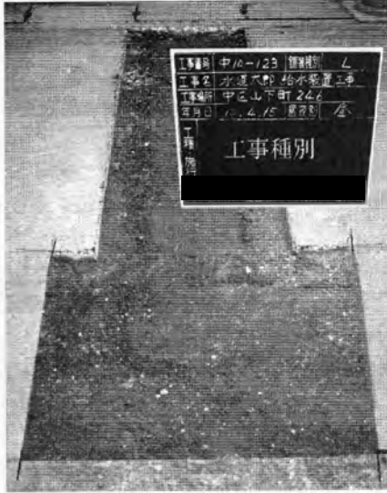
道路内路盤工完了状況写真
