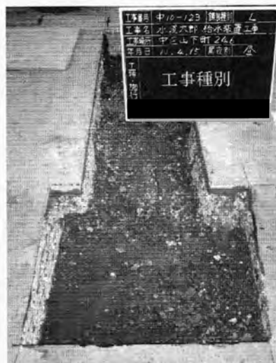
埋め戻し完了状況写真
