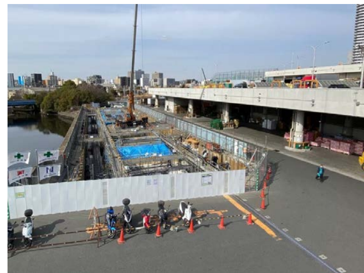
F 2 棟基礎工事の様子 (撮影：令和4年3月1日)
