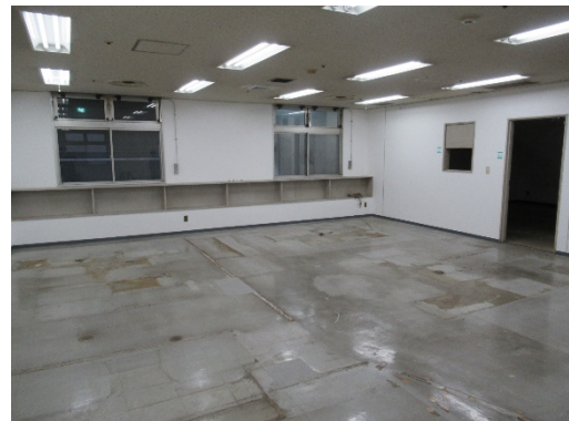
2階事務所 什器類撤去後
