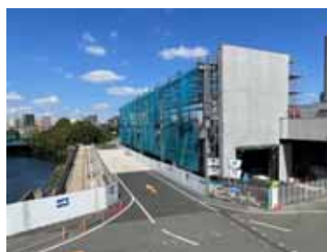
F 2 棟建築工事の様子 （撮影：令和 4 年 10 月 1 日）
