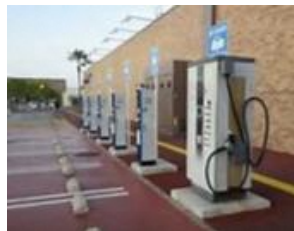
EV充電器の設置
