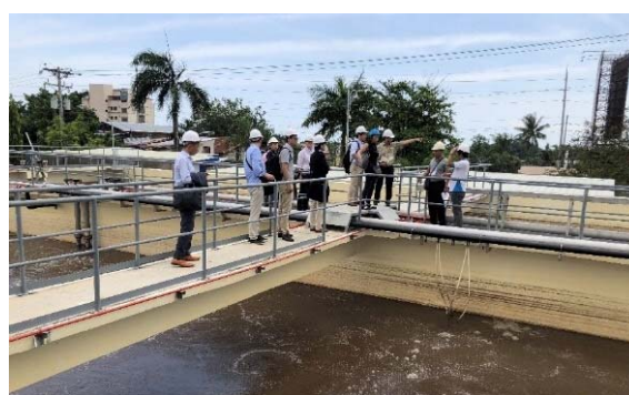
IT パークの排水処理設備(反応槽)
