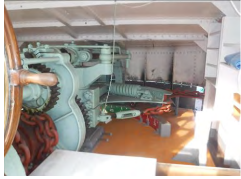
フード側壁基部切替え工事
