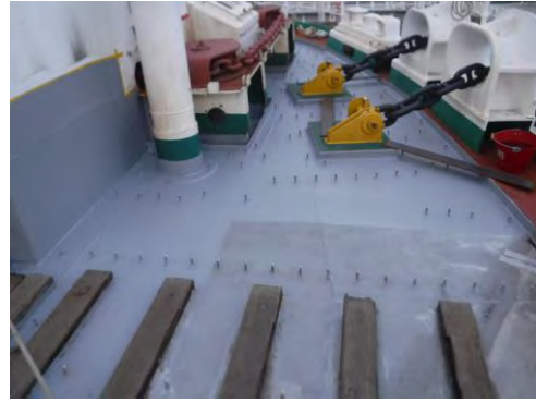
旧木甲板撤去後に整備された鋼製甲板
