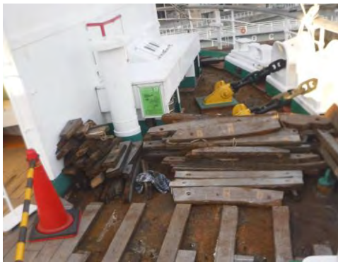
腐食した木甲板の撤去
