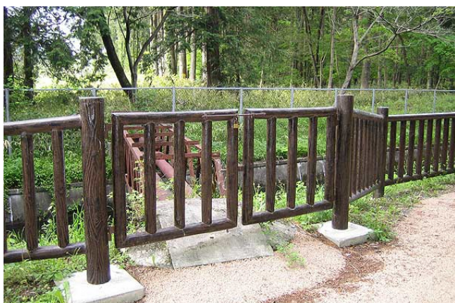
↑ 擬木開閉扉事例
