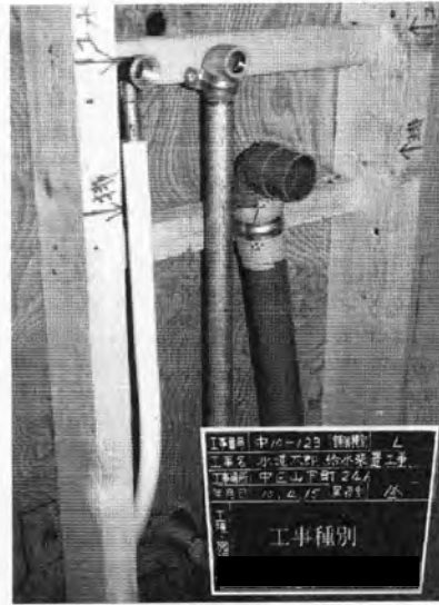
敷地内配管埋設及び隠へい部状況写真
