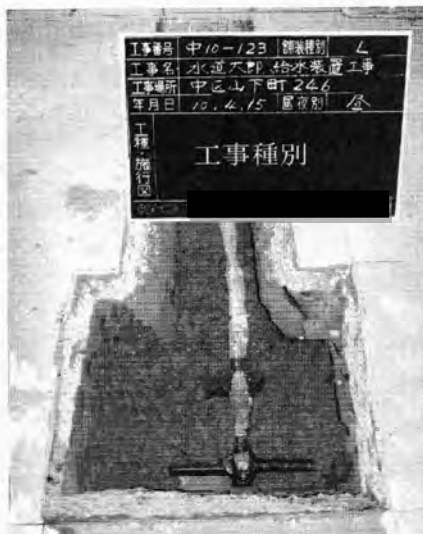
道路内配管施工状況写真
