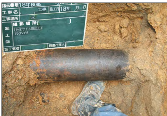
④ 給水管布設状況写真
