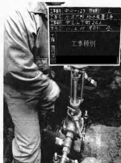
密着形コア挿入機設置状況
