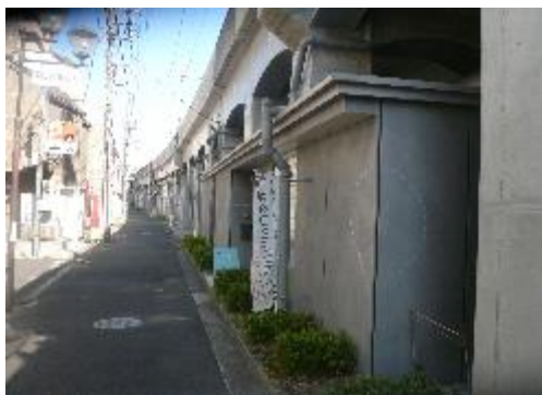
黄金町高架下の状況
