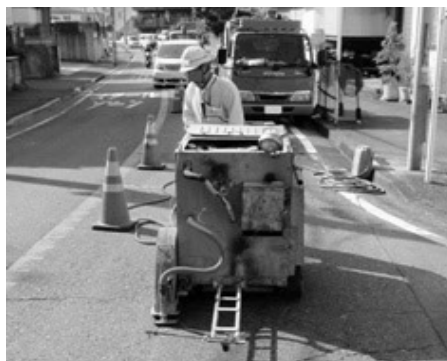
<舗装切断の施工例>
