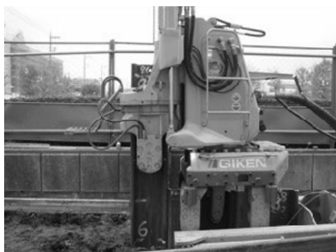
<鋼矢板圧入作業の施工例>
