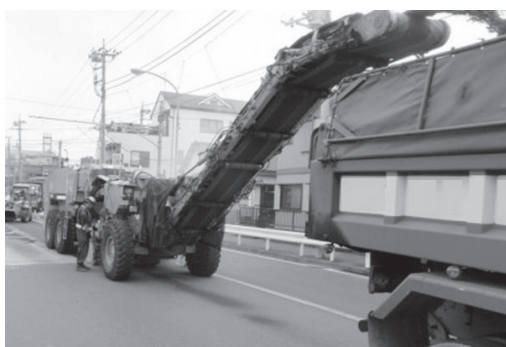
＜路面切削の施工例＞
