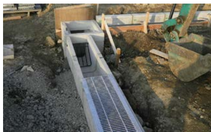
<延長 50m未満の排水構造物工のイメージ> <延長 50m以上の排水構造物工のイメージ>
