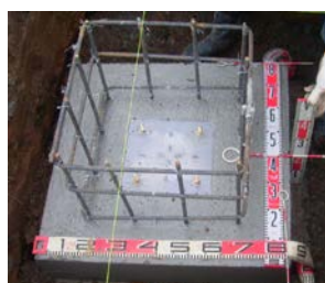
<小規模な鉄筋工のイメージ>
