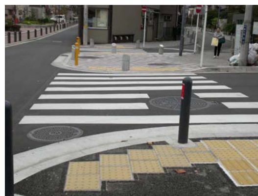
改善後の状況
