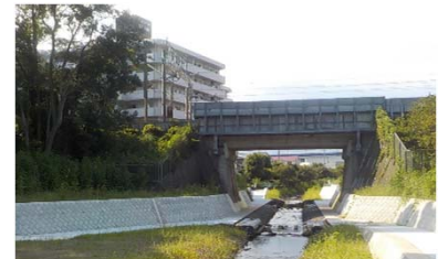
河川改修による護岸整備(和泉川)
