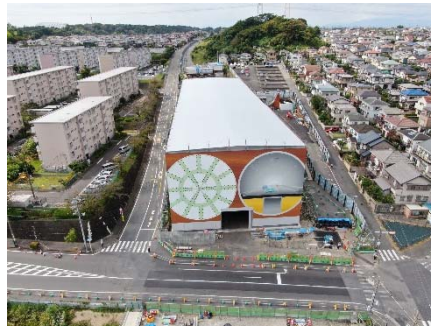
桂台トンネル工事(栄区上郷町)
