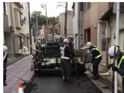
舗装修繕工事の状況(西区)
