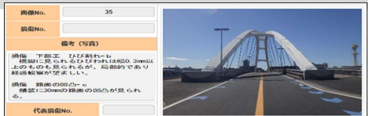
道路構造物管理システム 点検情報 【施設管理数】橋梁1715橋 歩道橋326橋 トンネル等100施設
