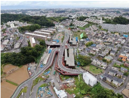
公田IC築造工事(栄区公田町)
