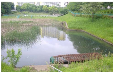
雨水調整池を活動場所とした水辺愛護会の新規結成 若葉台遊水池水辺愛護会(旭区)
