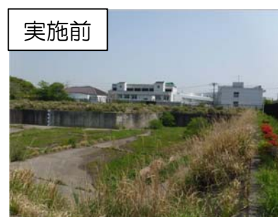
樹木伐採、除草、堆積土砂の掘削 (釜利谷南4丁目1号雨水調整池)
