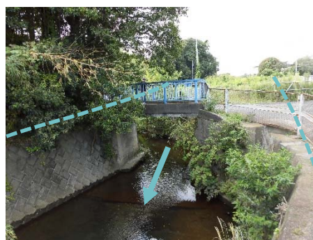
橋際橋架替え 阿久和川：泉区新橋町
