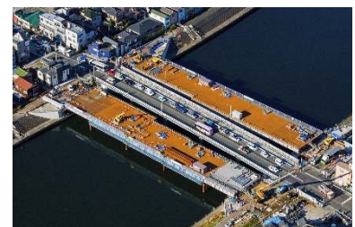
橋梁の架け替え(末吉橋)
