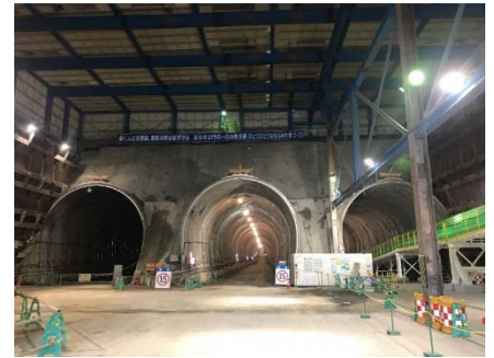
庄戸トンネル工事(栄区庄戸)
