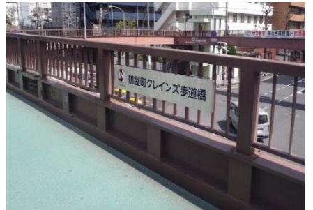
鶴屋町クレインズ歩道橋
