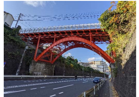
計画的な補修等: 打越橋(中区) (橋梁の塗装塗替)
