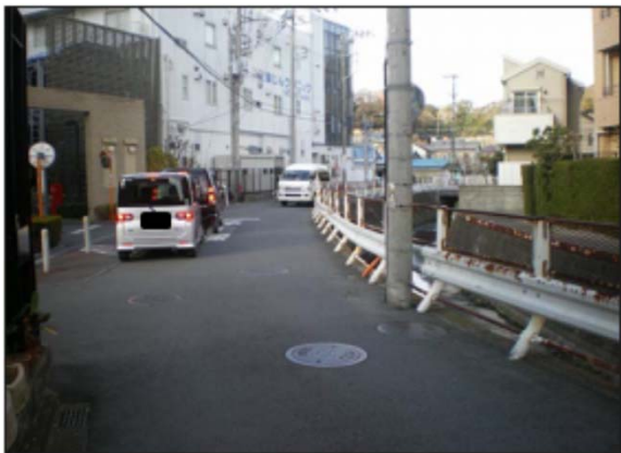
市道谷津第232号線(金沢区)
