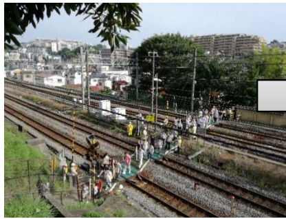
樹源寺踏切(保土ヶ谷区)現況
