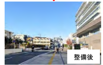
無電柱化の状況(港南区役所)
