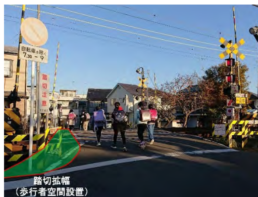
踏切拡幅 (歩行者空間設置) 金沢八景 (逗) 第2踏切 (金沢区: 京浜急行逗子線)
