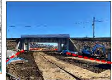
②工事が進む川崎町田線
