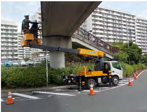
劣化状況の近接目視 小港橋歩道橋 (中区)
