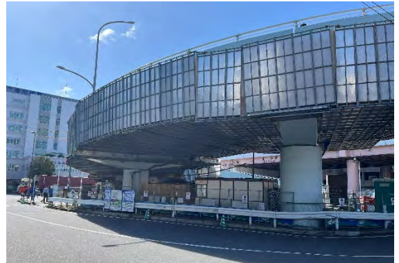
新子安橋(神奈川区): 桁、床板補修工事
