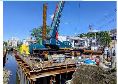
国道1号【保土ヶ谷橋工区】(保土ヶ谷区)
