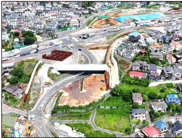
(仮称)戸塚IC工事の状況
