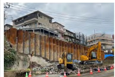
②トンネル坑口付近の擁壁工事
