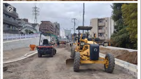
工事が進む鴨居上飯田線
