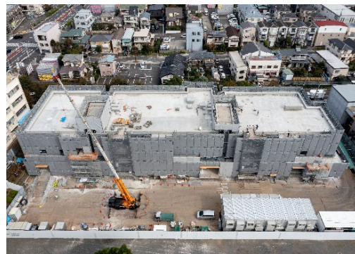
工事中的の写真
