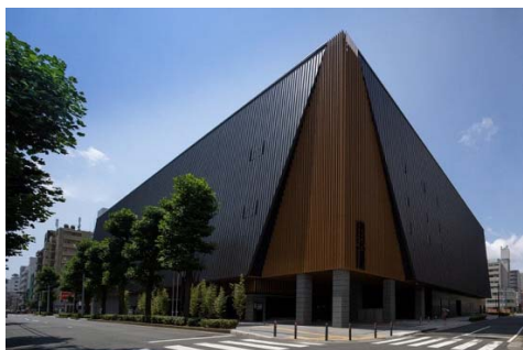
横浜武道館 外観
