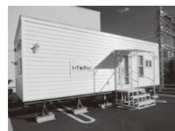
未来の家プロジェクト (スマートホーム実証実験)
