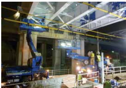
橋梁保護施工
