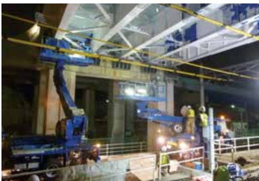
Trabajos de mantenimiento en una viga de puente
