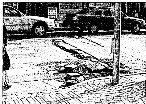
交差点での車道部の損傷
