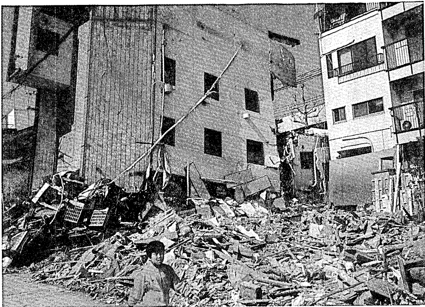
阪神淡路大震災における神戸市の一角。粉々に壊れた木造家屋、途中階から上転倒したビル、無傷のビルが同じ場所に存在する。
