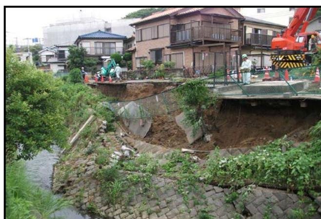
【老朽化による護岸崩落】（大岡川）
