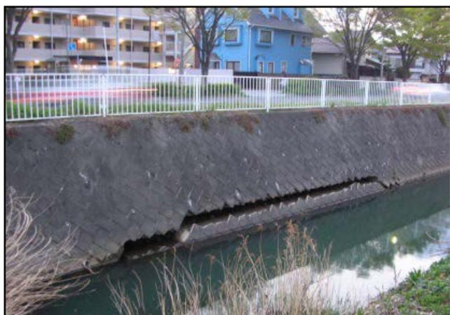
【老朽化による護岸崩落】
