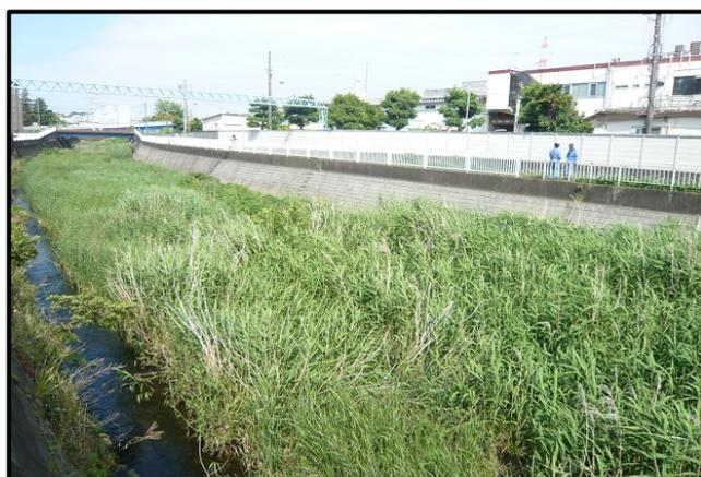
【土砂堆積による河積阻害】（平戸永谷川）
