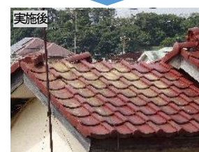
応急的危険回避措置の例
