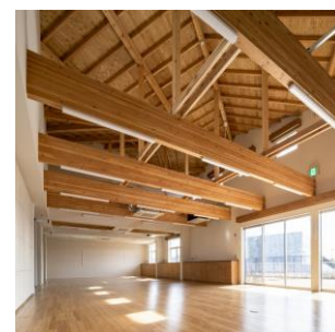
木造で整備した山下地域ケアプラザ
