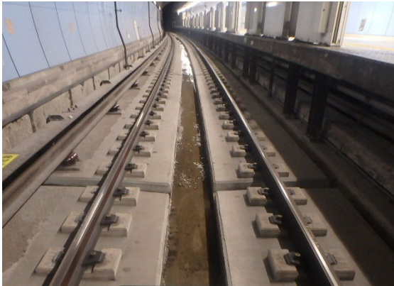
<軌道改良工事施工後>
