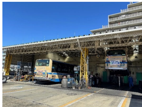
<緑営業所車両整備工場>
