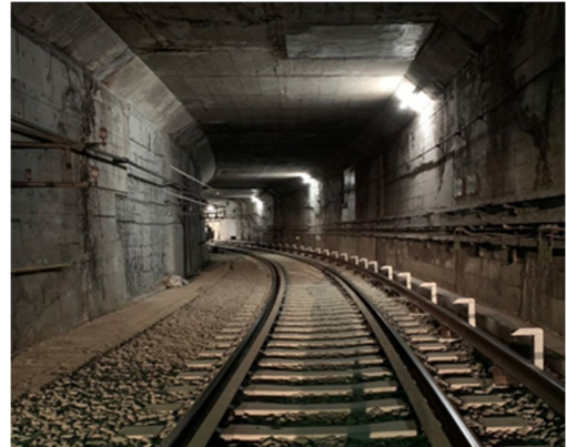
<急曲線軌道改良工事施工後>
