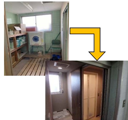
<執務環境改善（浴室改修）>
