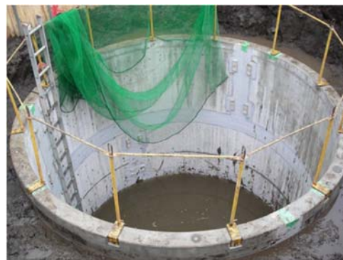
<防火水槽新設工事>
