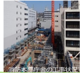
消防本部庁舎の工事状況
