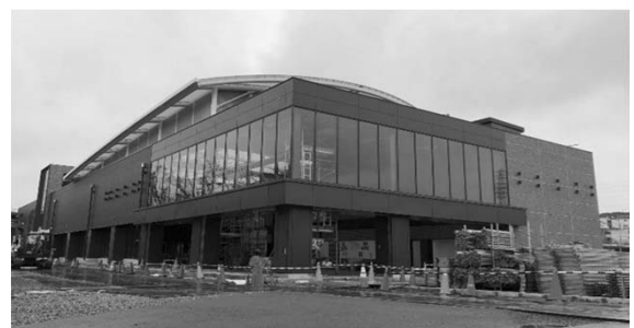
(参考) 羽沢横浜国大駅駅舎外観
