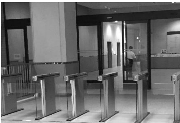
セキュリティゲート (横浜第二合同庁舎)
