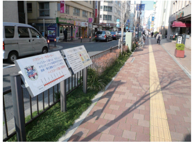
保水性舗装（ベイスターズ通り）
