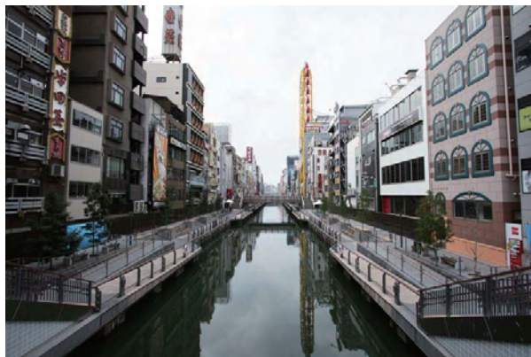
大阪・道頓堀では、河川沿いのプロムナードの整備をきっかけに、裏を向けていた建物が川沿いに開口部を設け始めている。
