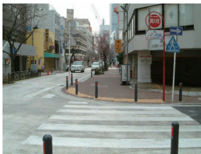
整備後（平成18年）
