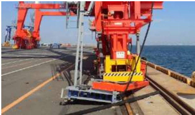
ガントリークレーン電源ケーブル逸脱
