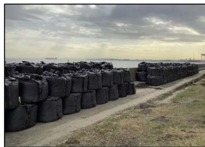
耐候性土のうによる仮復旧 (左)第1ライン、(右)第2ライン
