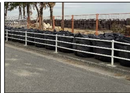
耐候性土のうによる仮復旧 (左)第1ライン、(右)第2ライン
