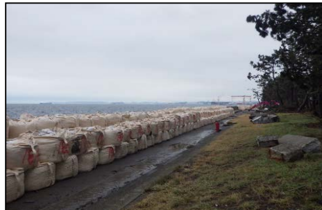
護岸応急復旧(福浦地区)
