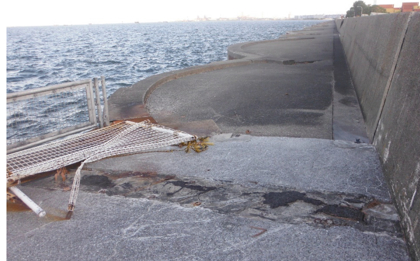
鋼板セル式護岸の上部工【本牧ふ頭D突堤】
