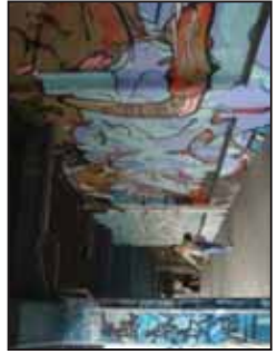
補修・補強工事前
