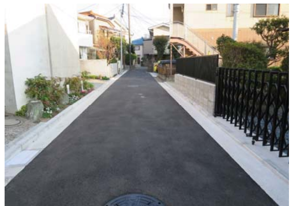
H29 狭あい道路拡幅整備 寺前一丁目
