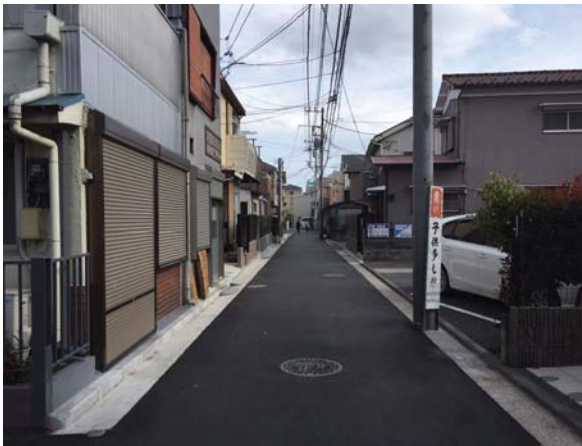
道路整備 拡幅 1056.7m
