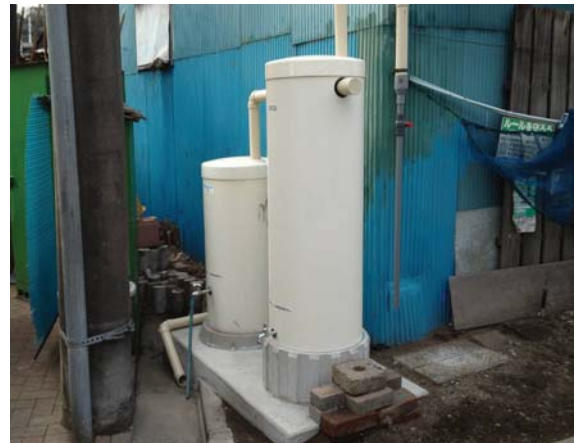
雨水タンク整備(300ℓ) 1箇所
