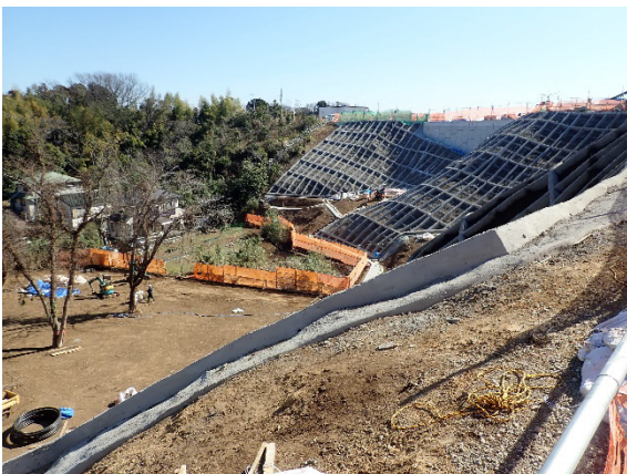
施工後(令和5年3月)
