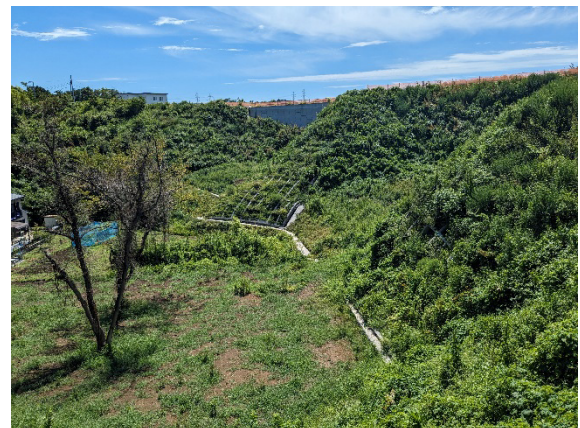
現況(令和5年6月)
