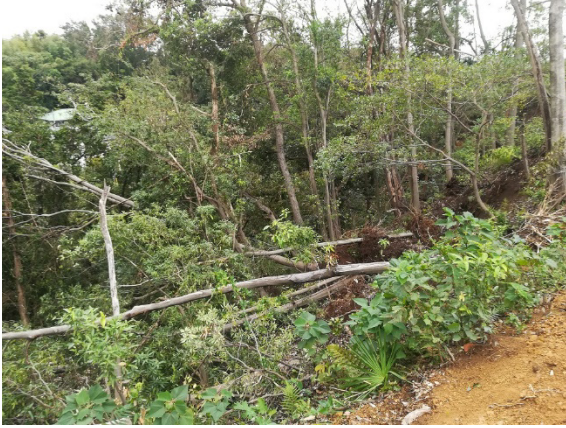
施工前(倒木状況)
