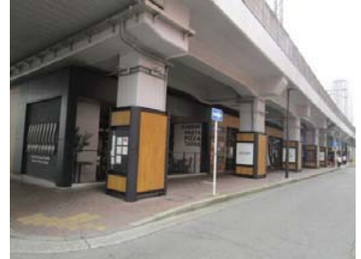
東急東横線・目黒線新丸子～武蔵小杉間高架下
