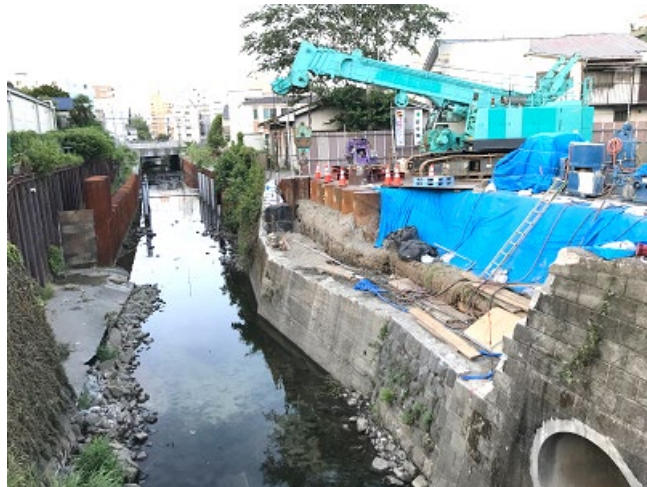
元保土ヶ谷一丁目交番付近の河川工事
