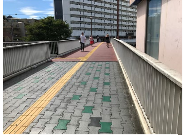
保土ヶ谷駅東口歩道橋
