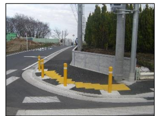
整備後の歩道
