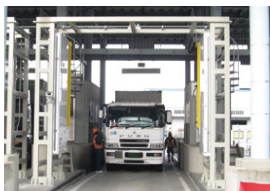
図8 据置型の放射線検知装置（整備中）
