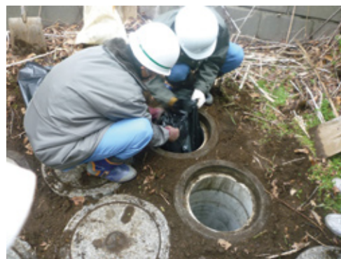
現場施工の様子
