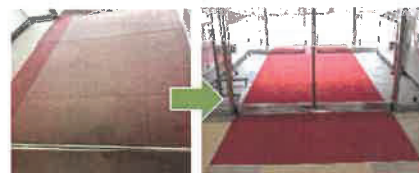
汚損が著しい入口のマットを更新
