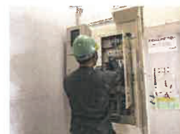
営繕チームの点検の様子
