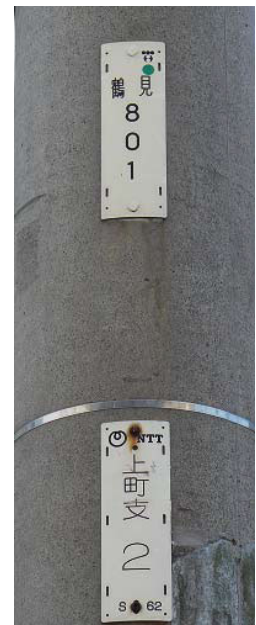
東京電力も使用しているNTT柱
