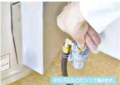
4. コックの位置がタンクの底辺より上にあるためタンクに灯油を3L以上入れ、プラケースの上に置いて、コックを開きます。
