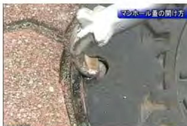
**手順3** マンホール蓋を開けると塩ビ製の内蓋を開け、仮設トイレを設置するためにマンホール蓋の蝶番を外し、枠から分離させます。
