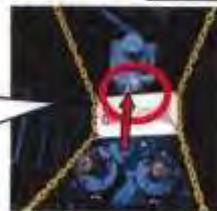
バルブキーで止水バルブをゆっくり右（時計回り）に回して水圧確認をします。3分後無圧が確認できたら、バルブを必ず閉めて以後の作業にかかります。
