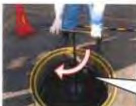
消火栓のキャップを外し、矢印の部分にバルブキーを立てます。
