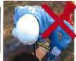
バルブキーを回して3分後水が出続ける場合、タンク内に有圧なので応急給水を行うことはできません。バルブキーをゆっくり左（反時計回り）に回して消火栓を止め、蓋を閉め器材を備蓄庫へ戻します。
