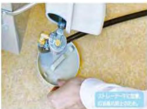
6. 金ネジ部から灯油が出てきて、泡→透明な灯油になったら締めます。ストレーナーについた灯油は雑巾で拭き取ってください。
