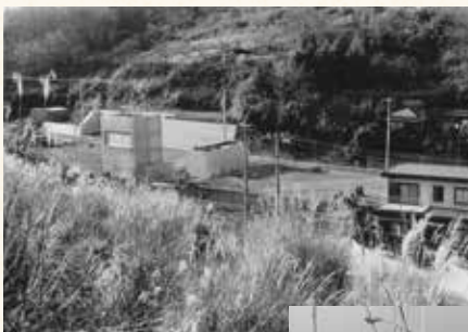
工事中的下永谷駅
