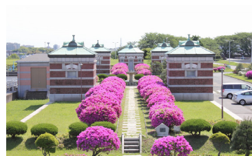
西谷浄水場濾過池整水室上屋3号棟 他
