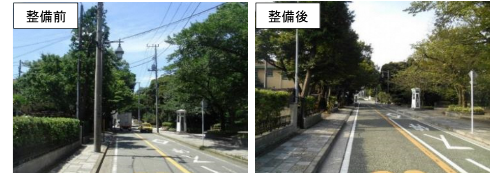
中区・山手本通り元町公園付近(平成25(2013)年度完成)
