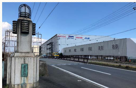
寿老橋右岸上流より橋面を望む。
