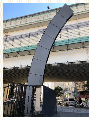
北幸橋の親柱・照明柱
