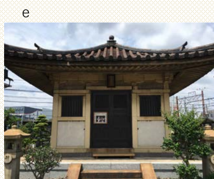
慶運寺観音堂の外観
