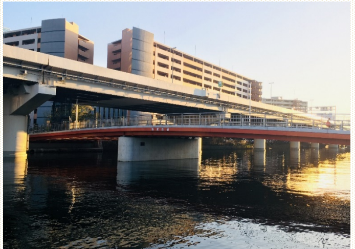
架替後の新浦島橋を北東側から望む。架替前は川の中に4つの橋脚があったが、架替後は1つになった(令和元年(2019)撮影)
