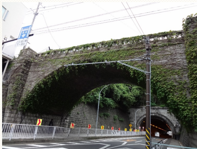
m 櫻道橋（昭和3年竣工） 中区麦田町1丁目13番地先
