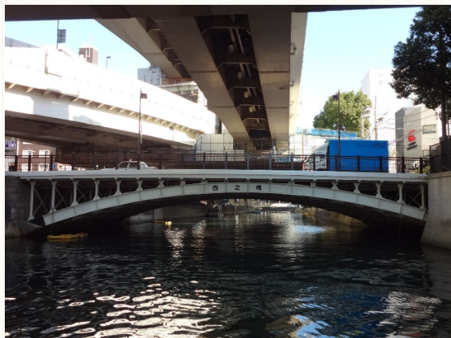
n 西の橋（大正15年竣工） 中区山下町276番地先
