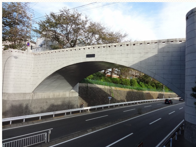
l 霞橋（昭和3年竣工） 西区霞ヶ丘56番地18地先
