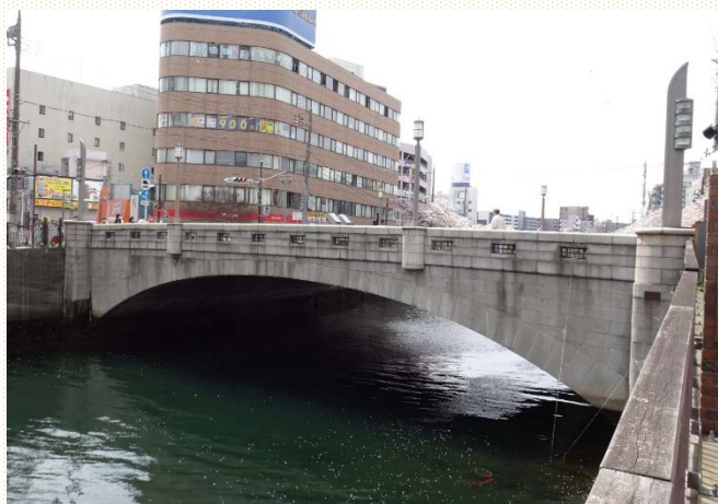
p 長者橋（昭和3年竣工） 中区長者町9番地176地先
