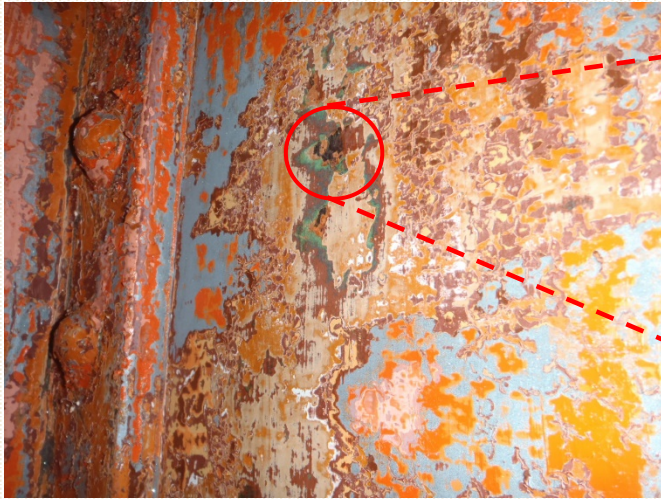
g 塗替工事の施工中写真
