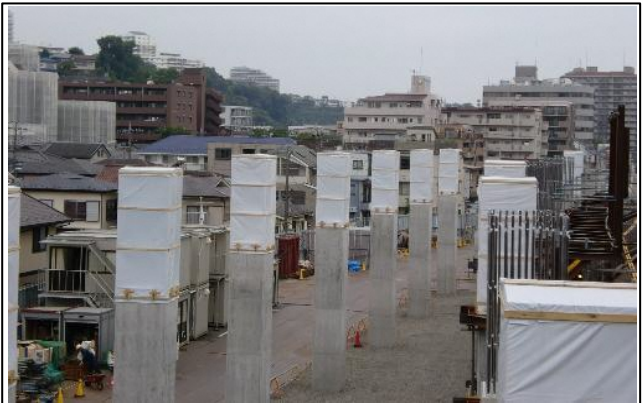
写真② 天王町2号～3号踏切間橋脚施工状況 (海老名方を望む)
