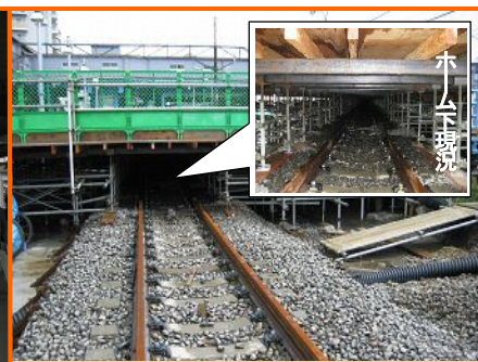
写真一④ 上りホーム下現況 (平成20年5月 撮影)
