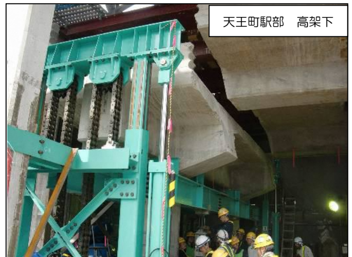
写真④ 天王町駅の既設構造物を撤去しています
