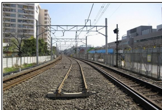
写真-③ 天王町1～2号踏切間における 仮下り線敷設状況
