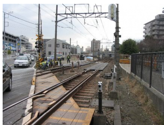
移設工事中の星川2号踏切付近（平成19年1月撮影）
