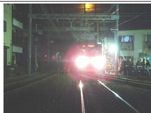
写真③ 切替え箇所を走行する試運転列車 ：星川6号踏切付近（平成19年11月撮影）
