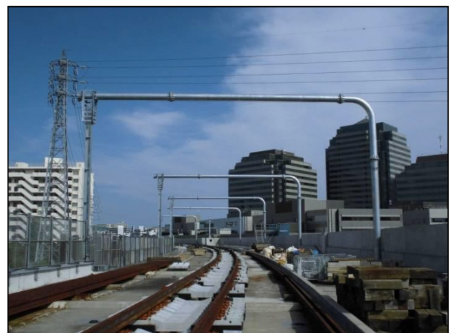
写真④ 電柱の設置状況
