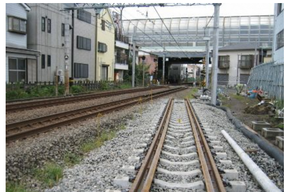
写真一③ 星川6号踏切付近の終点方切替え箇所 (平成19年10月撮影)
