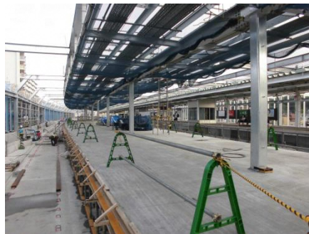
写真2. 星川駅上りホーム構築
