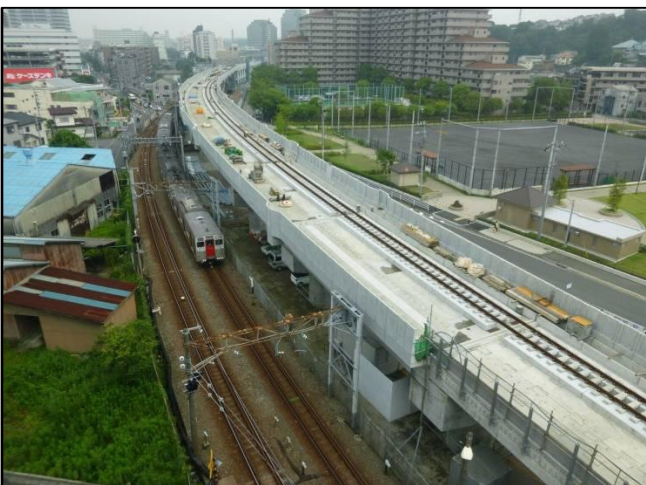
写真③ 下り線のレール敷設状況
