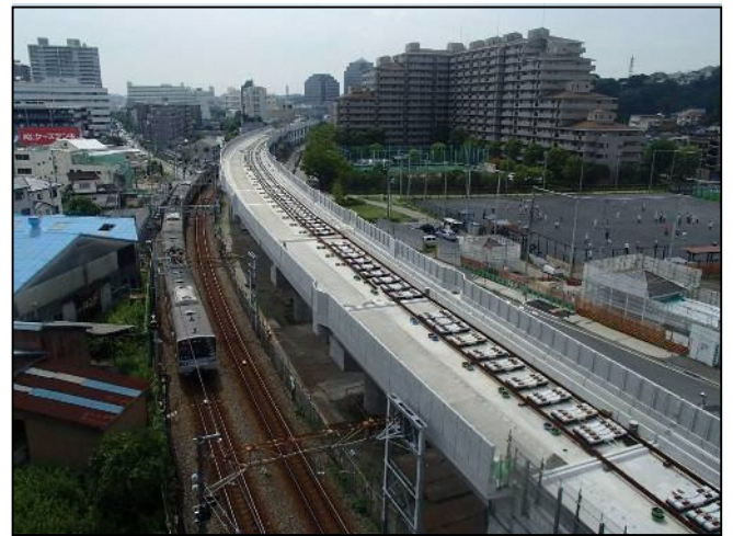
写真② 星川3号踏切から星川駅方面を望む
