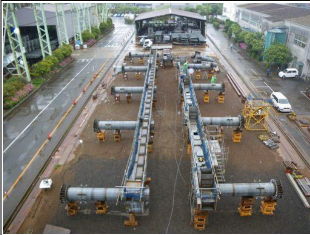
写真-③ 星川駅部高架橋仮組立状況
