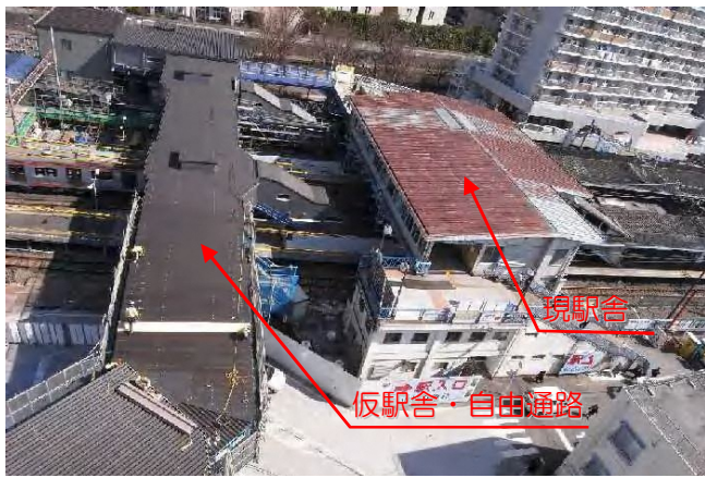
写真一① 現在の星川駅（仮駅舎工事中）
