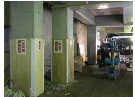
写真3. 天王町駅舎躯体構築
