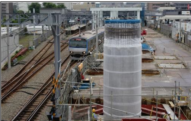
写真③ 星川第1架道橋部橋脚施工状況 (横浜方を望む)
