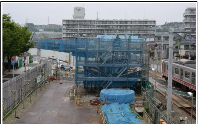
写真④ 星川第2架道橋部橋脚施工状況 (海老名方を望む)
