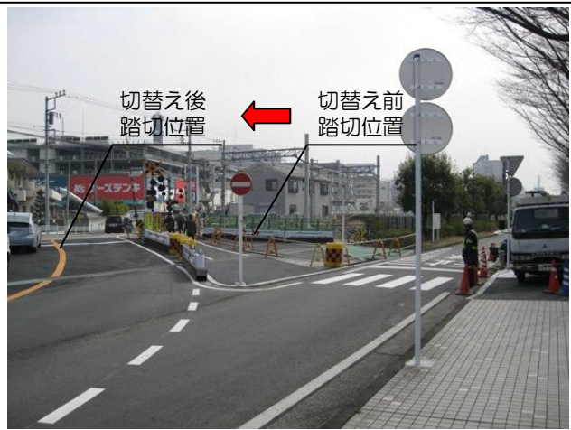
写真-⑤ 切替え後（南側から北側を望む）
