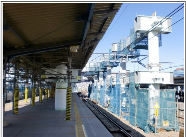
写真-② 星川駅1～3番線間鉄骨架設状況 （下りホーム横浜方から海老名方を望む）
