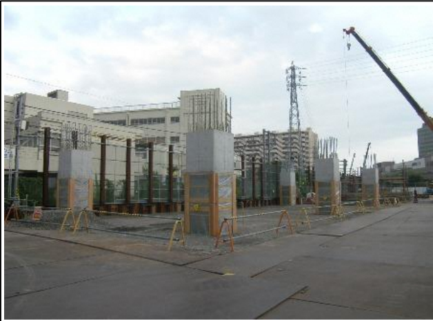
写真-④ 高架橋の躯体構築状況 (天王町2号～3号踏切間南側から横浜方を望む)
