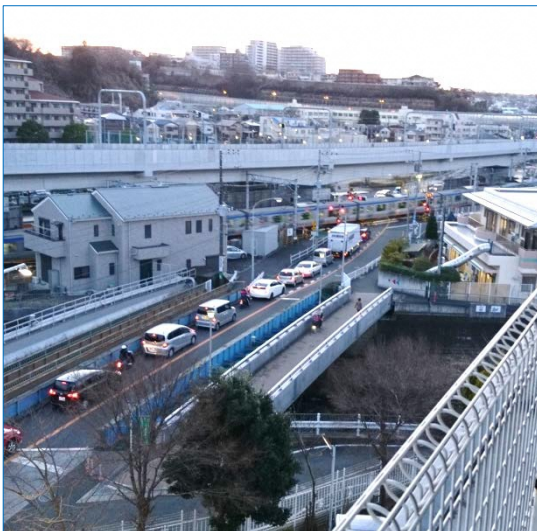
星川2号踏切 高架化前
