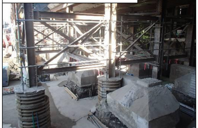
写真⑥ 天王町駅の基礎工事の状況
