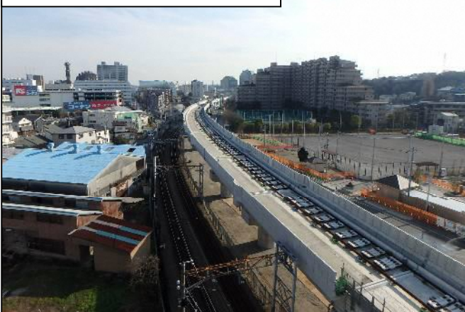
写真⑤ 星川3号踏切付近
