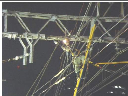
写真② 軌道の切替えに伴う架線調整作業 （平成19年11月撮影）
