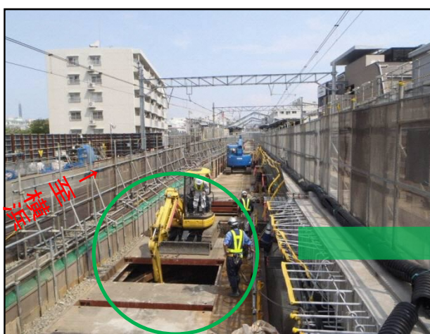
写真 1. 上り線の掘削状況①
