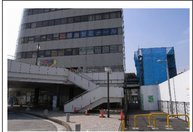
写真一⑤ 建設中の南側改札外エレベーター （平成19年10月撮影）
