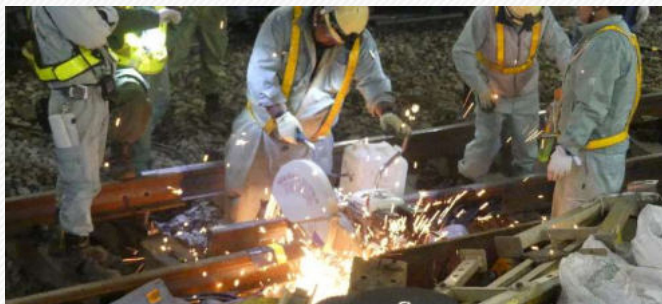
切替のため線路を切断しています
