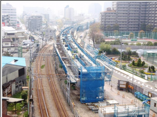
写真-④ 星川2号踏切付近桁架設状況 （海老名方から横浜方を望む）
