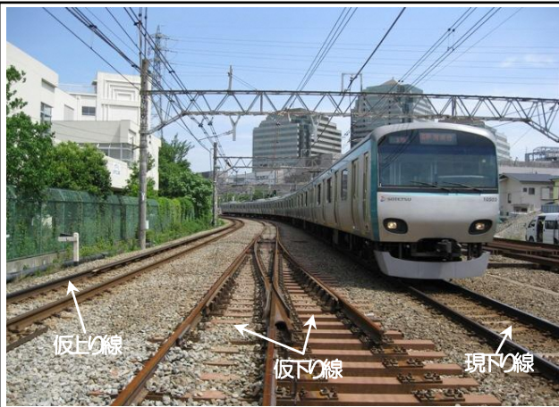
写真④ 天王町2号～3号踏切間軌道敷設状況 (天王町3号踏切付近より横浜方面を望む)
