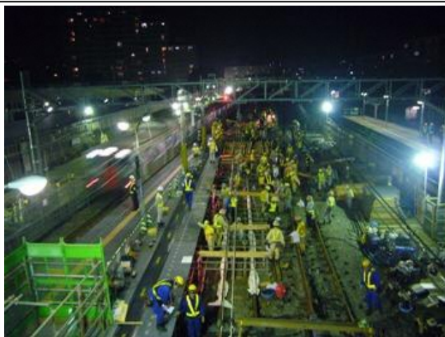
写真-③ 星川駅2番線のホーム拡幅作業（海老名方を望む）
