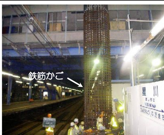
写真-⑤ 鉄筋かご挿入状況
