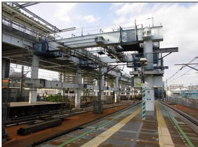
写真③ 星川駅上りホームの海老名側
