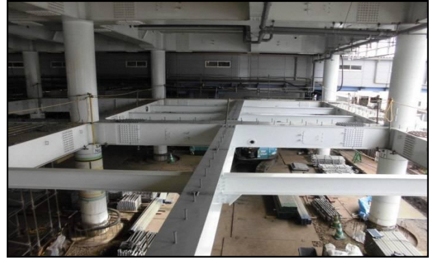
写真6.コンコース階の工事状況
