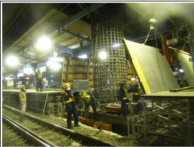
写真-①星川駅下りホーム下鉄筋かご建込み状況
