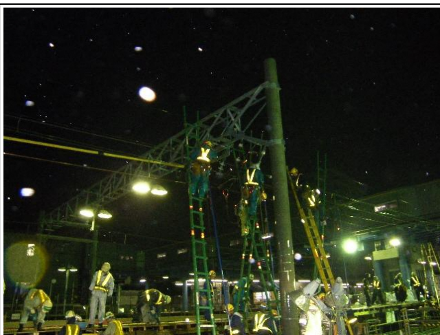
写真-③ 架線切替え調整作業 （星川駅1番線より北側を望む）
