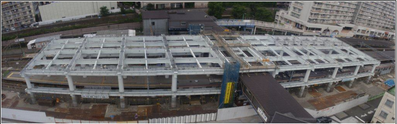
写真-⑤ 星川駅鉄骨架設状況（南側から北側を望む）
