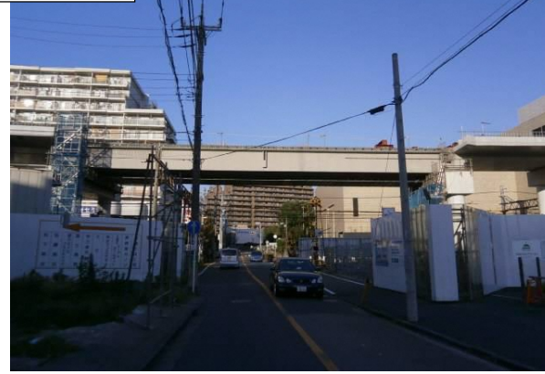
天王町第 3 架道橋桁架設完了 (南側から北側を望む)
