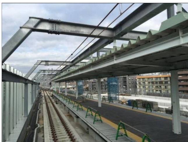
写真1。星川駅の新しい下りホーム
