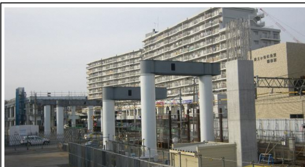
写真-② 天王町第3号踏切付近鉄骨架設状況 （横浜方から海老名方を望む）
