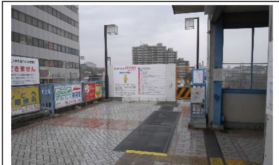
写真-④ 閉鎖した星川SFビル連絡通路 (平成19年12月撮影)
