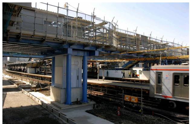
仮跨線橋に設置された改札内上り線用エレベーター この位置に仮設ホームが設置される（平成19年4月撮影）
