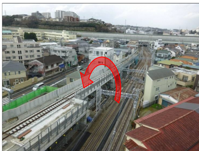
写真2。現在の下り線から高架橋上への切替（星川4号踏切付近）
