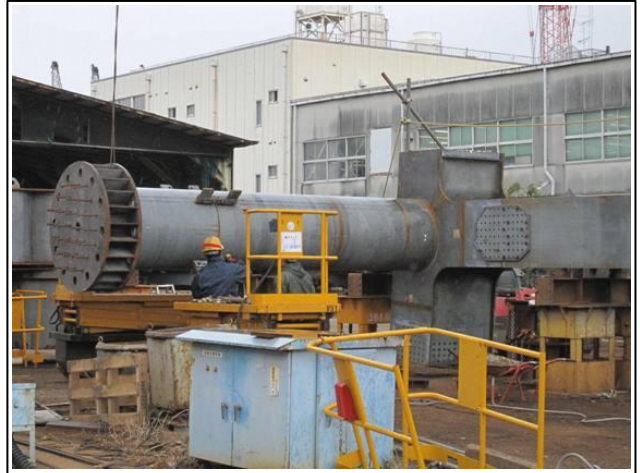
写真-④ 星川駅部高架橋柱仮組立状況
