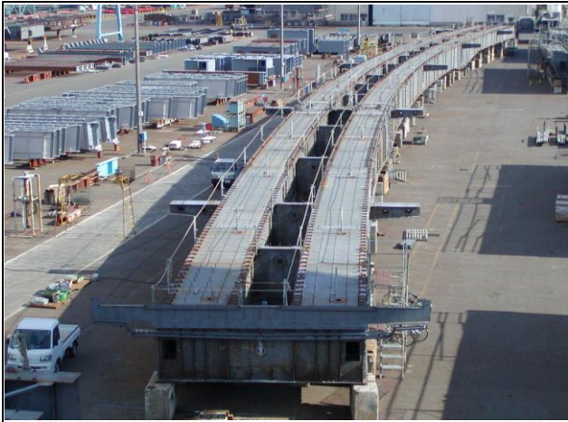
写真-④ 星川第2架道橋製作状況 （工場での仮組み検査）
