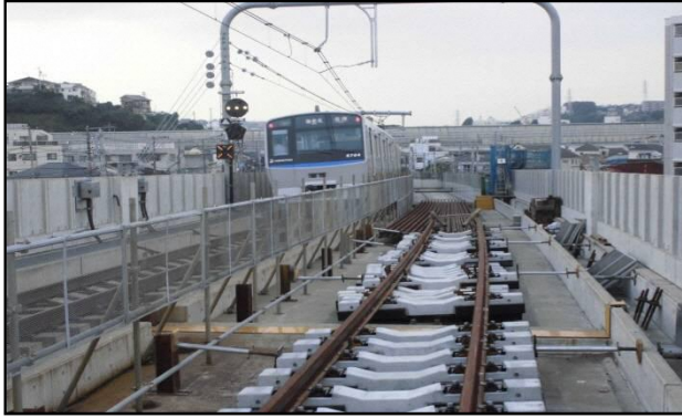
写真5.上り線のレール敷設状況
