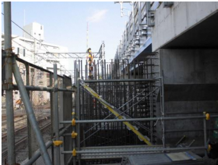
写真1. 上り線用躯体構築
