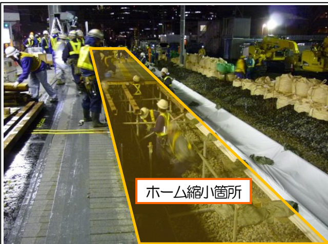
写真-① 星川駅下りホーム縮小作業 （星川駅1番線ホームより横浜方を望む）
