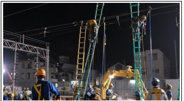
写真-② 架線切替え調整作業（天王町3号踏切横兵方）
