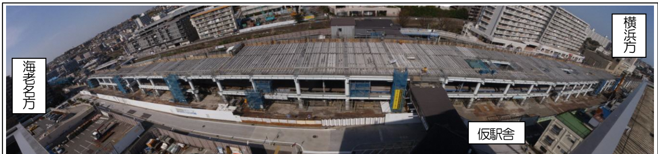
写真-① 星川駅鉄骨架設、3階乗降ホーム階スラブ架設状況（全景） （南側から北側を望む）
