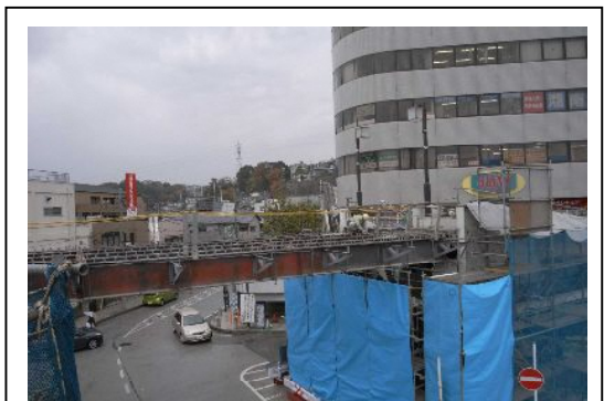
写真-⑤ 撤去作業の進む星川SFビル連絡通路 (平成19年12月撮影)
