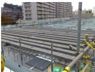
架設状況写真
