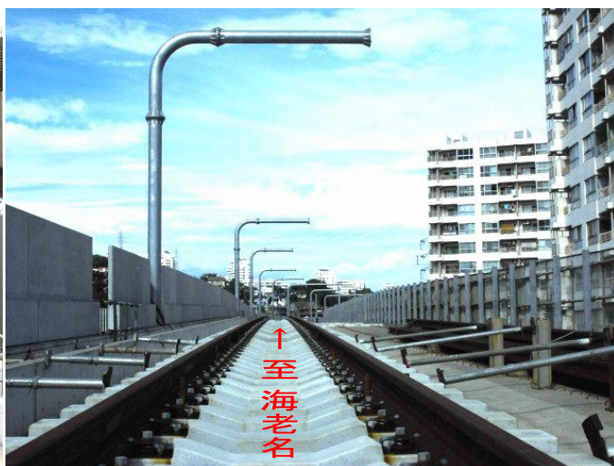
写真② レールと電柱の設置状況（天王町1号踏切付近）
