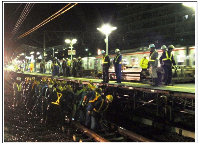
写真-② 人力によるレールの振込み作業 （星川駅1番線より海老名方を望む）
