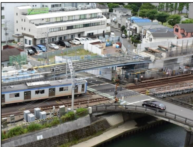
写真① 天王町1号架道橋の設置状況
