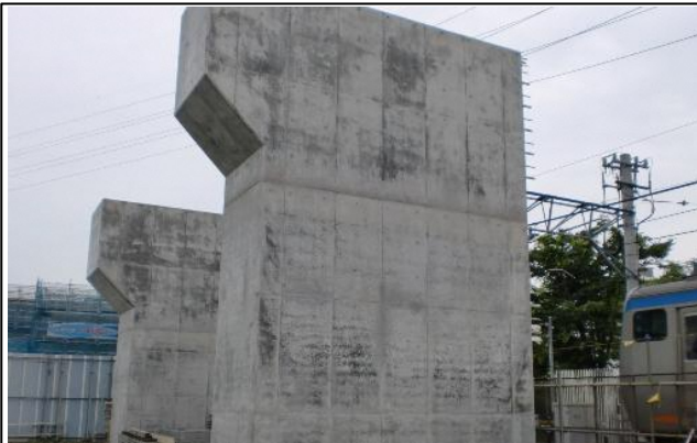
写真① 天王町第2架道橋部橋脚施工状況 (海老名方を望む)
