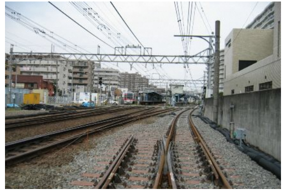
写真一② 星川駅横浜方の切替え箇所 (平成19年10月撮影)
