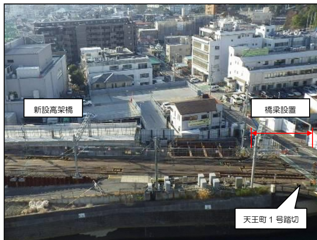
写真② 天王町 1 号踏切付近
