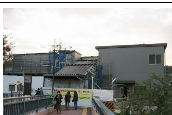
星川駅で進めている仮駅舎建設工事 (平成18年12月星川下橋より撮影)
