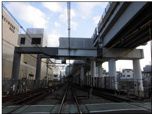
写真④ 天王町 3 号踏切付近
