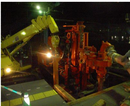
写真-④ 地盤掘削状況
