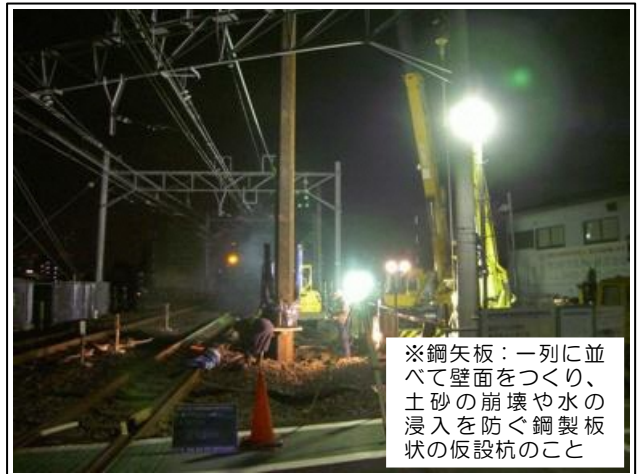
写真-② 鋼矢板打設状況（天王町1号踏切横浜方）
