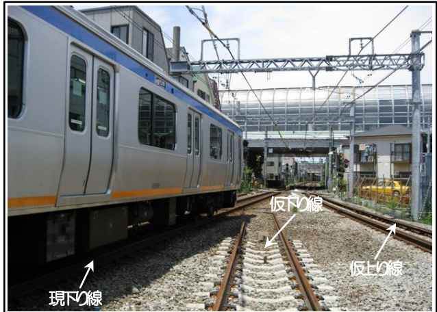
写真⑤ 星川4号～6号踏切間軌道敷設状況 (星川4号踏切付近より海老名方面を望む)
