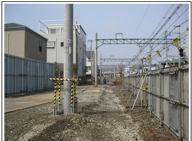
写真-③ 施工ヤード整備状況（星川3号踏切付近から海老名方を望む）
