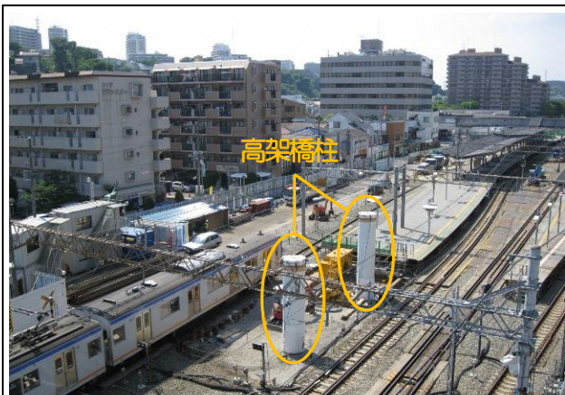
写真-① 天王町3号踏切の高架橋柱の状況 （天王町3号踏切から海老名方を望む）
