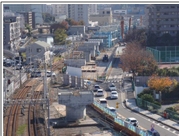
写真-② 星川2号踏切付近橋脚施工状況 （海老名方から横浜方を望む）
