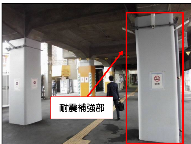
写真 3. 耐震補強した柱
